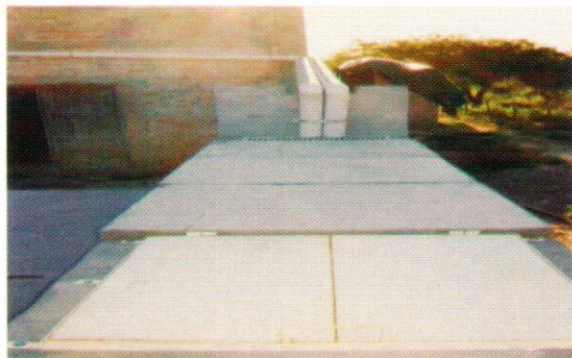
Filtro de arena y piedra
