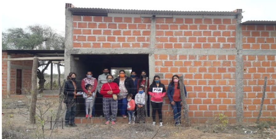
Obra en construcción de la sala de faena en Morillo.
