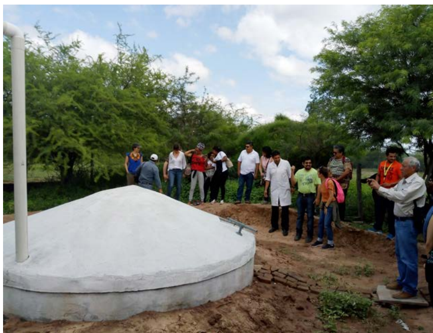
La cisterna para cosecha de agua de lluvia que se construyó en la Escuela N° 4815.
