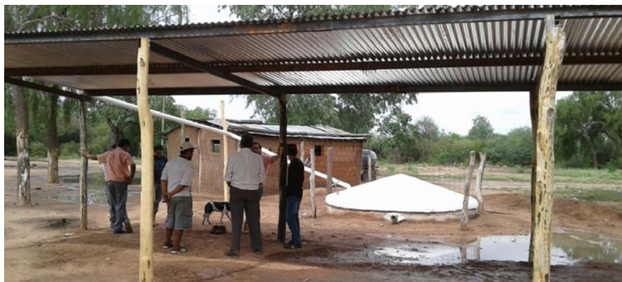
Una cisterna para cosechar agua de lluvia en Los Blancos, Salta.
