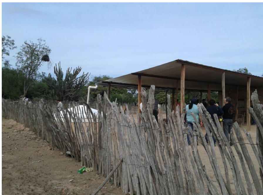
Una cisterna de cosecha de agua de lluvia en el paraje Los Ancos en Morillo, Salta.
