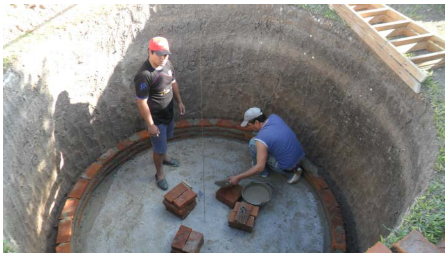
Construcción de aljibe en Santa Lucía (INTA Reconquista)
